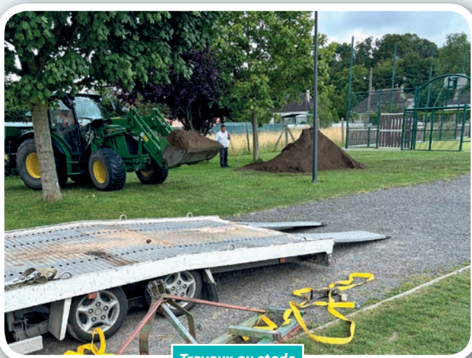
Travaux au stade
