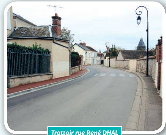
Trottoir rue René DHAL
