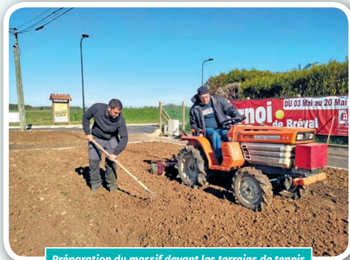
Préparation du massif devant les terrains de tennis
